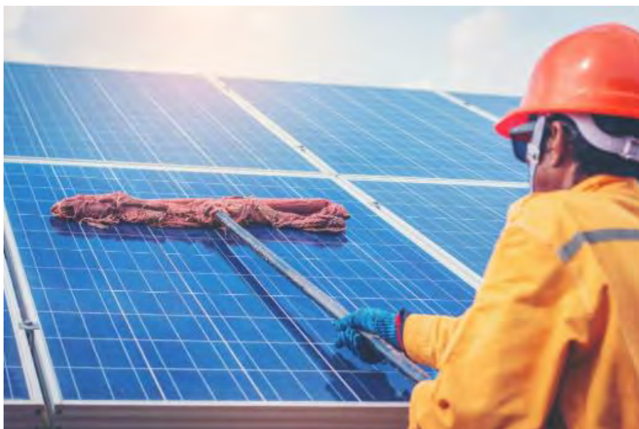
Figura 32 - Limpeza dos painéis fotovoltaicos utilizando rodo, pano e detergente neutro
