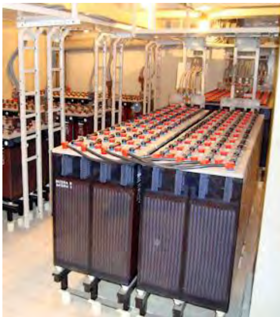
Figura 25 - Banco de Baterias em operação
